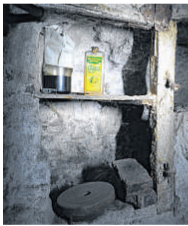
Die Kellerwände gehören zum Teil zur einstigen Stadtmauer.
