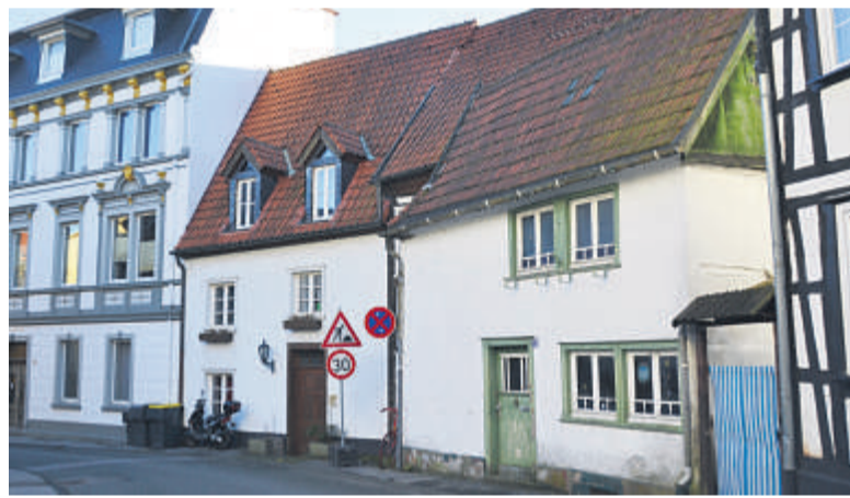
Nach der baulichen Bestandsaufnahme rechnet der Verein „Iserlohn – denkmal“ damit, dass die Sanierung im kommenden Jahr erfolgen kann.
